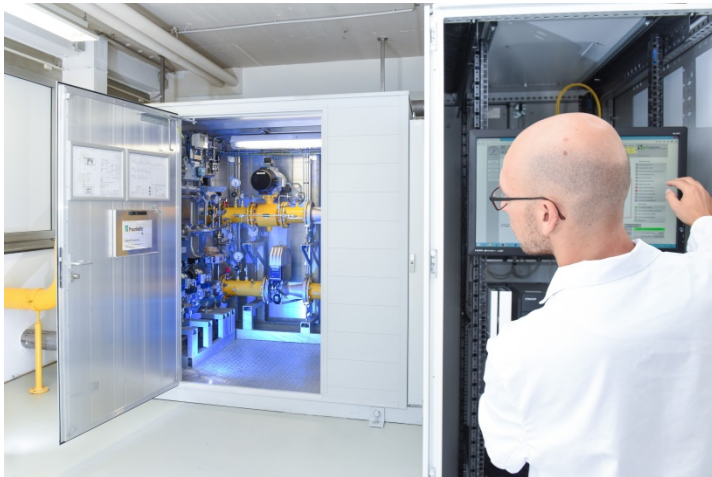
In einer Pilotanlage erprobt das Fraunhofer ISE bereits seit zwei Jahren die Wasserstoffeinspeisung in das Erdgasverteilnetz. © Fraunhofer ISE/Joscha Feuerstein
